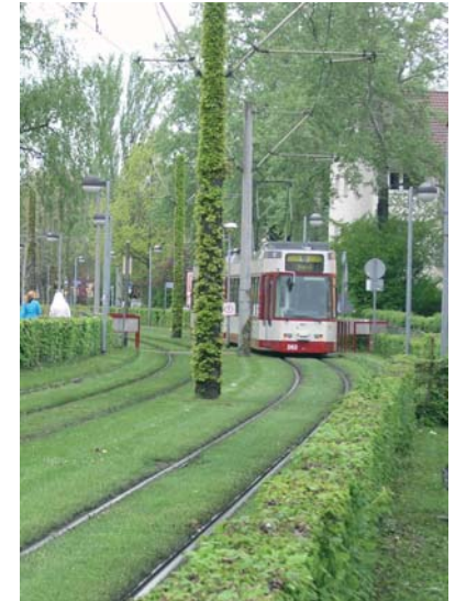
Kotomäessä raitiovaunu on osa puistoa. Nurmetettu rata ei pölyä ja vaimentaa melua.
